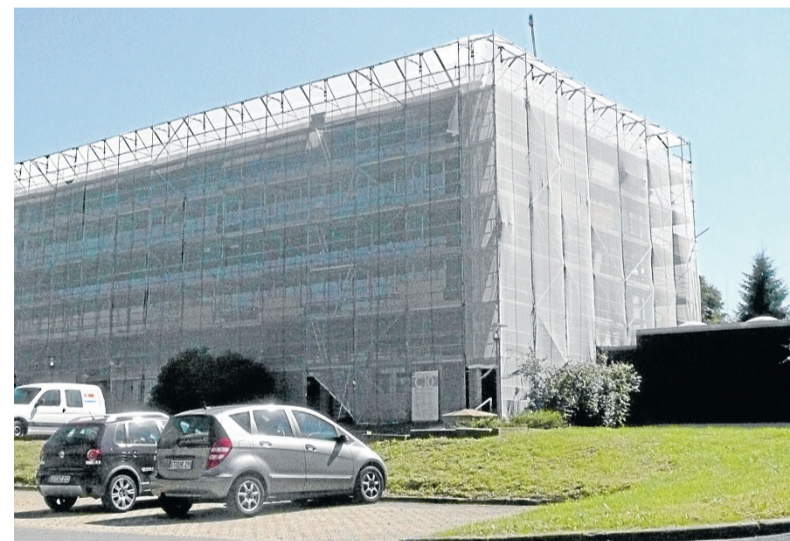
Allein die laufende energetische Sanierung des Geophysik-Gebäudes der TU Clausthal wird etwa 1,8 Millionen Euro kosten. Foto: Dieter Böhl
